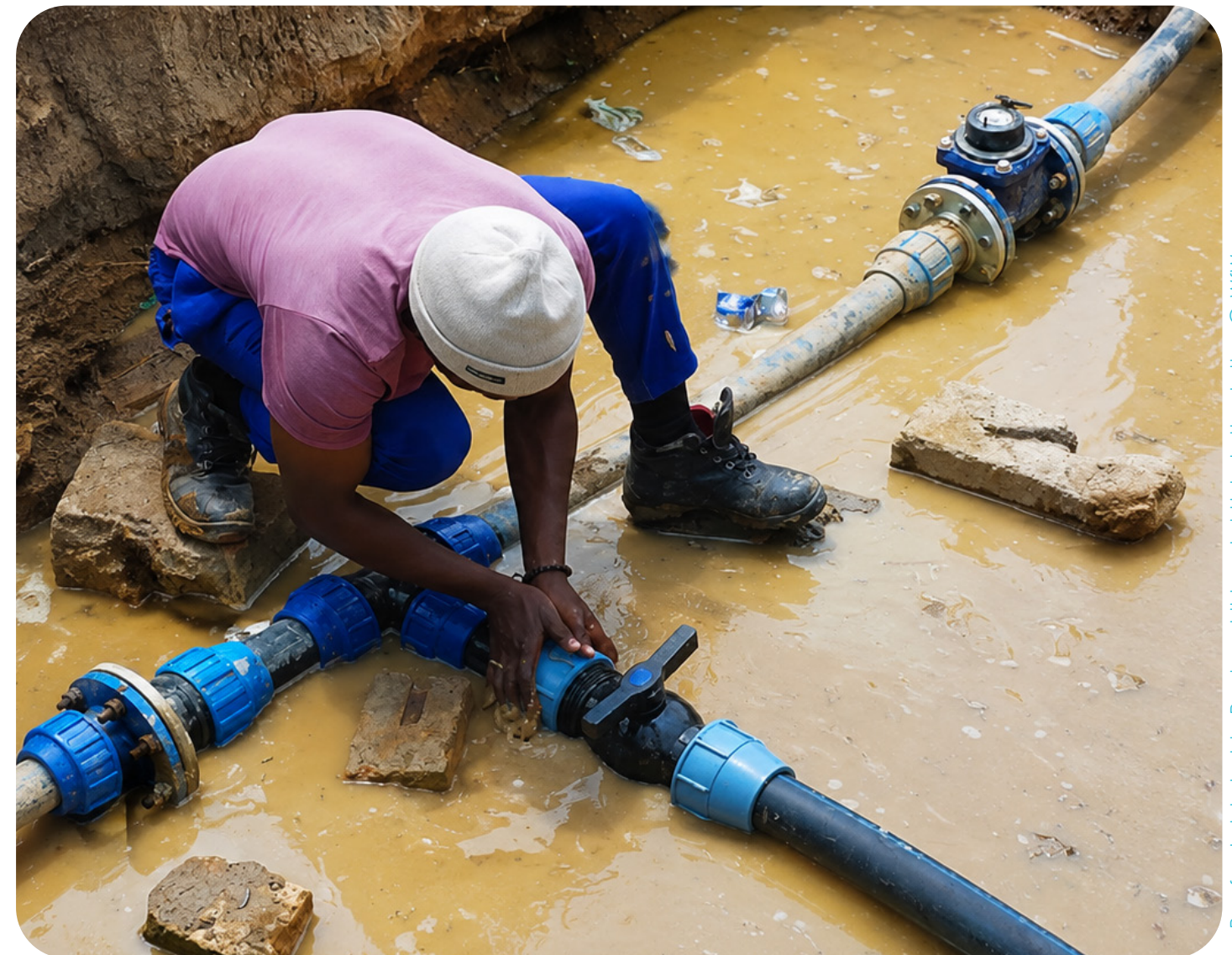
Berufsschulstudent in Praxisausbildung bei Unterhaltsarbeiten © WfW
