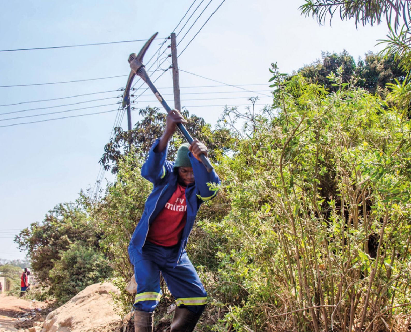
Bauarbeiten in Linda, Lusaka | WfW
