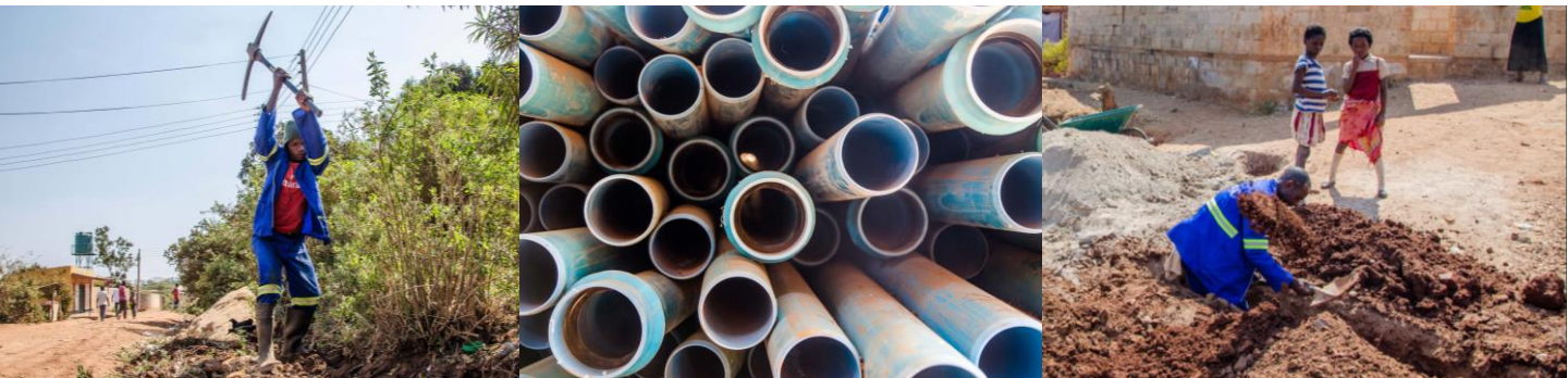
Fotos: Bauarbeiten, August 2015
